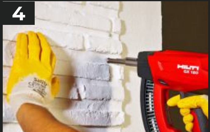
4. Anbringen mit Nägeln ... Assembling by nails ...
