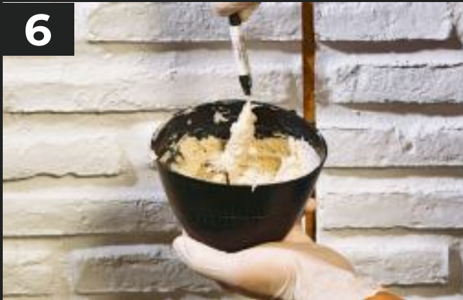
6. Spachtelmasse vorbereiten Preparing the assembly putty
