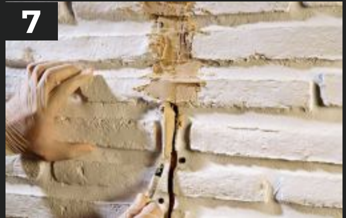
7. Zwischenräume mithilfe eines Spachtelmessers mit Spachtelmasse füllen Covering the spaces by assembly putty by using a putty knife
