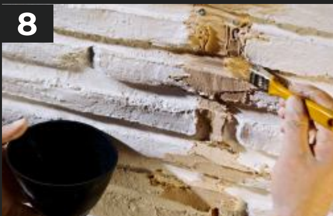
8. Spachtelmasse Mit Pinsel und Spachtel in Form bringen Whiping into shape by brush and putty knife
