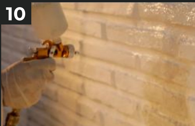
10. Spachtelkanten Mithilfe von Airbrush nachbessern Re-touch painting by airbrush
