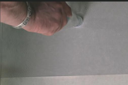
Anschließend werden die Löcher mit beiliegender Spachtelmasse ausgefüllt und z.B. mit einer Glasflasche in Form gebracht.
