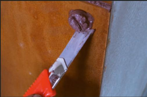
Werden diese mit der beiliegenden Fugenmasse fixiert und bestrichen, so ergibt sich ein täuschend echtes Ergebnis.
